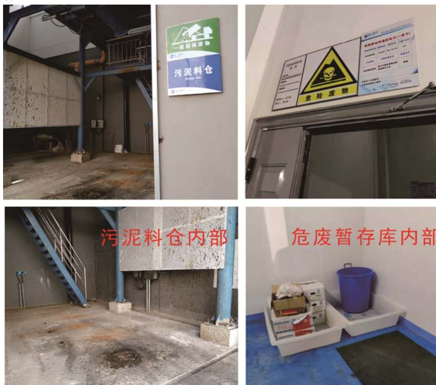
图 2-9 固废暂存设施
